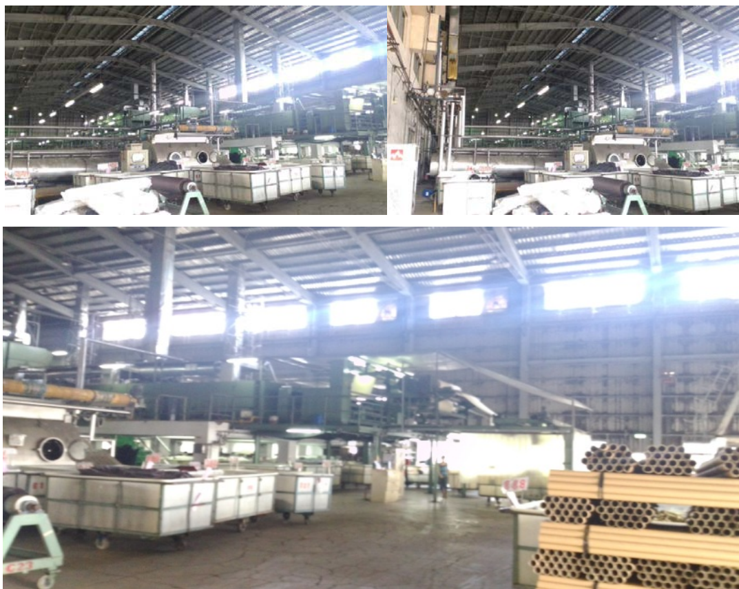
圖 34 D場所廠房現場照片
