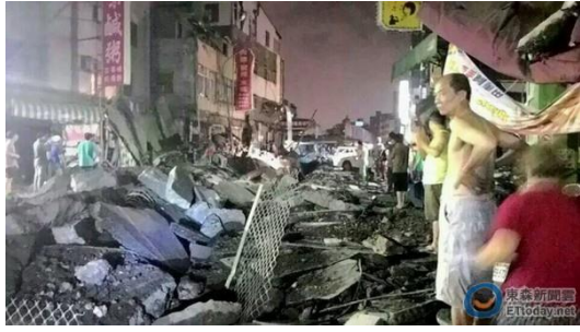
氣爆現場狀況 5
