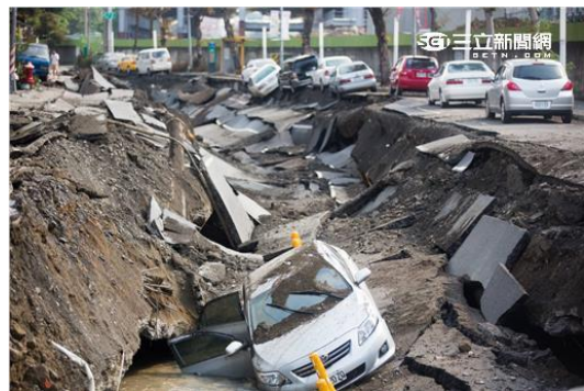
氣爆現場狀況 2
