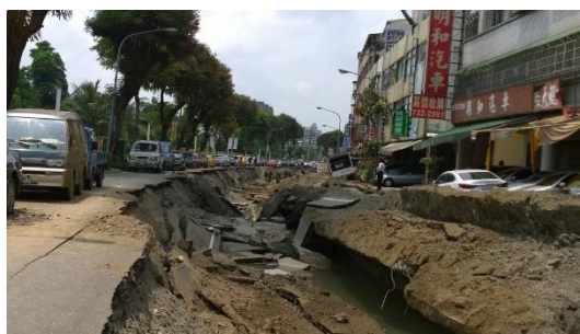
氣爆現場狀況 3
