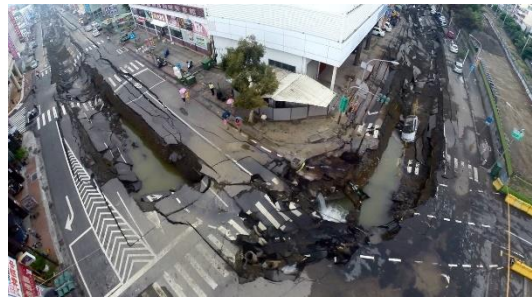
氣爆現場狀況 6
