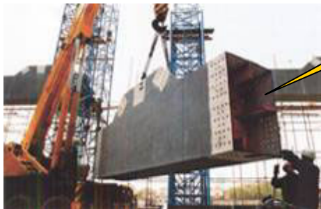
รูป 2.3 – เมื่อปฏิบัติงานวางแผ่นกันดิน จะต้องขันน๊อตด้วยให้แน่นเพื่อป้องกันแผ่นเหล็กหล่นลงมา
