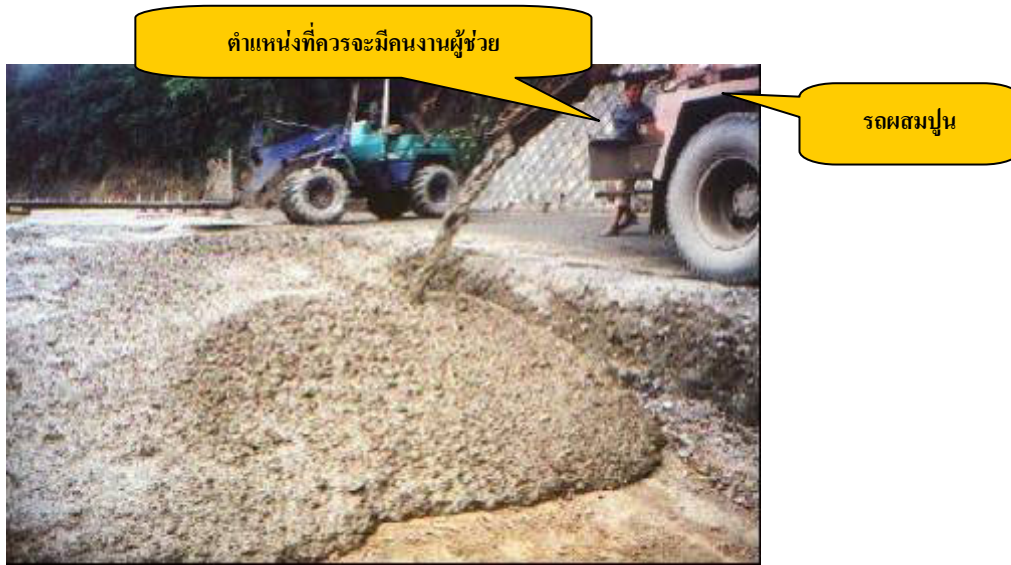
รูป 2.1 - ตำแหน่งที่ควรจะมีคนงานผู้ช่วยและควรจะมีรั้วกันบริเวณที่รถผสมปูนทำงาน
