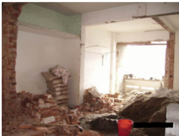
รูป 2.5 – กำแพงอิฐที่พังทลายลงมา ควรจะมีป้ายเตือนภัยและรั้วกันบริเวณทำงาน เช่นเดียวกับรูป 2.4
