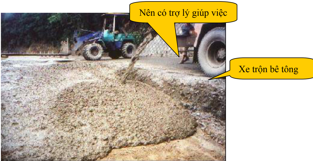
Hình 2.1 Trong phạm vi xe trộn bê tông đang thi công cần lắp đặt hệ thống lan can cách ly bảo hộ, khi lùi nên có trợ lý hỗ trợ
