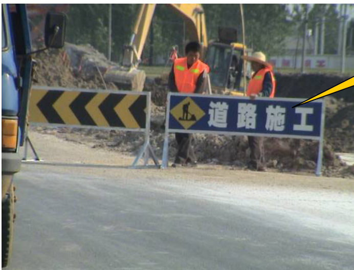
Hình 2.4 Trong phạm vi thi công cần lắp đặt hệ thống lan can bảo vệ an toàn
