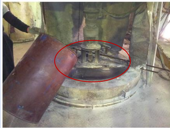
圖二 廢料添加至熔爐作業
