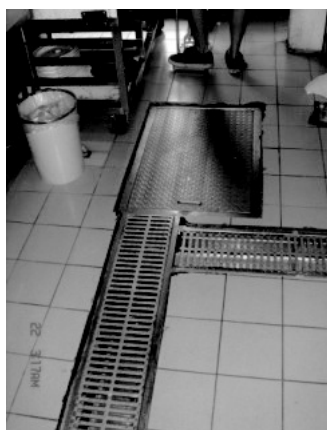
圖3 某西餐廳廚房之排水蓋
