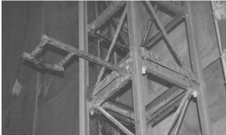
照片3 施工電梯之電纜導架(照片中由塔柱伸出之方框即是 ) (資料來源：本計劃參與人員自行拍攝)
