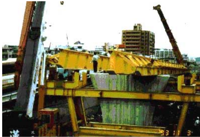
照片1 預鑄預力節塊吊裝工法支撐鋼樑吊放 (資料來源：本計劃參與人員自行拍攝)
