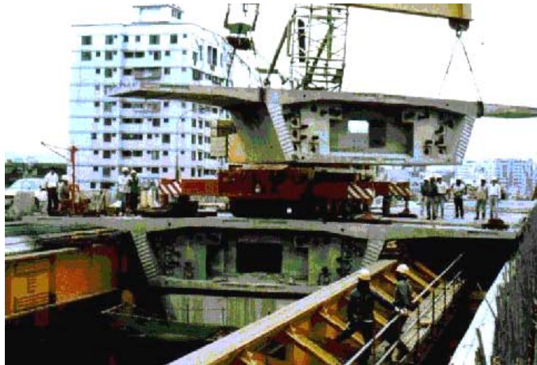
照片2 預鑄預力節塊吊裝 (資料來源：本計劃參與人員自行拍攝)
