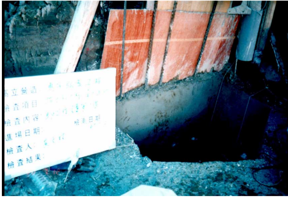
照片7 護圈之安全防護設施(資料來源：台北市工礦安全衛生技師公會)
