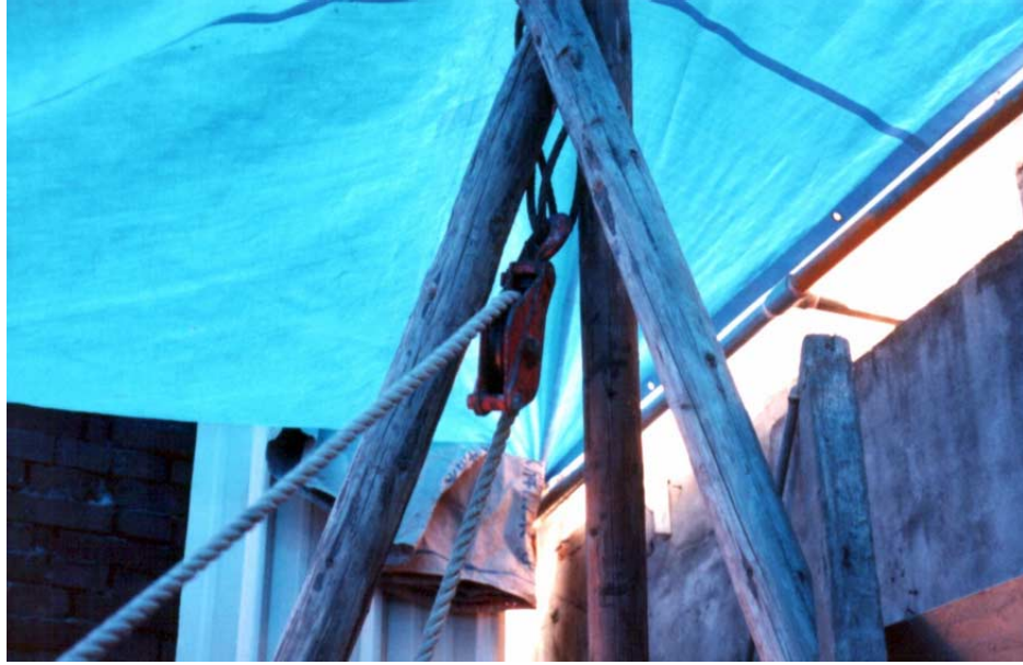
照片3 三角架與滑輪組(資料來源：台北市工礦安全衛生技師公會)
