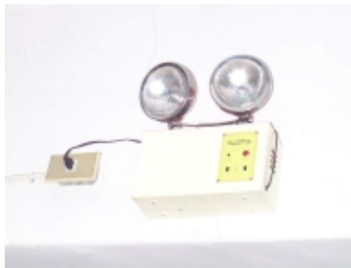
圖 1 典型掛牆式的緊急照明燈
