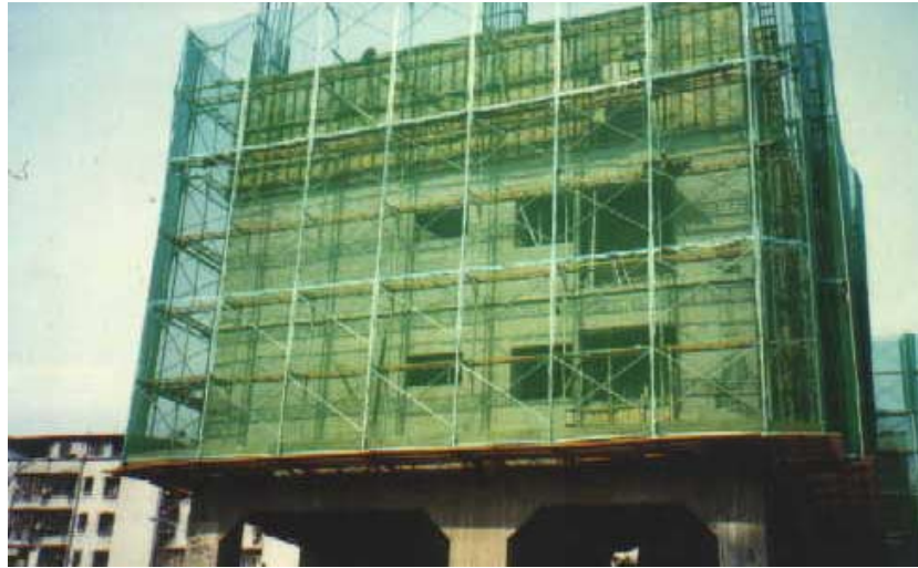
照片1 施工架應組立確實並定期檢查(資料來源：根基營造(股)公司)
