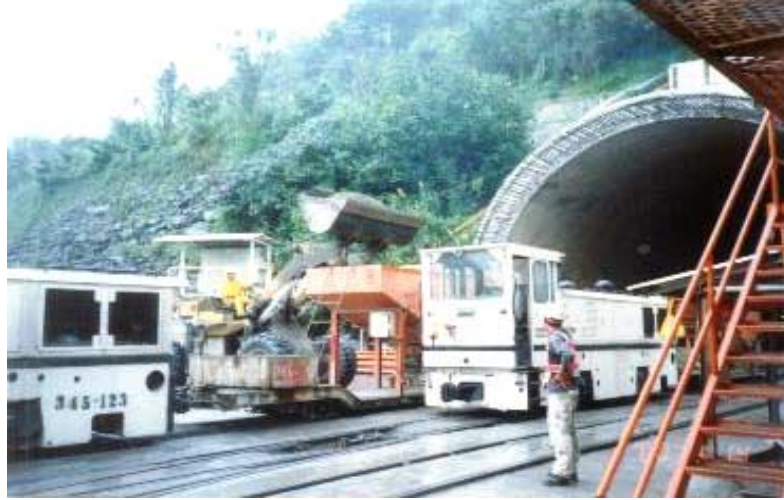
照片5 TBM施工之物料裝運作業
