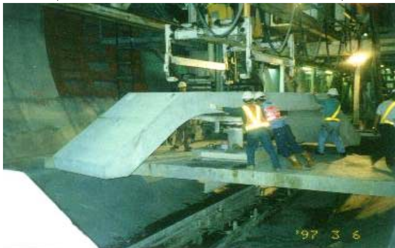
照片4 TBM施工之仰拱環片組裝作業
