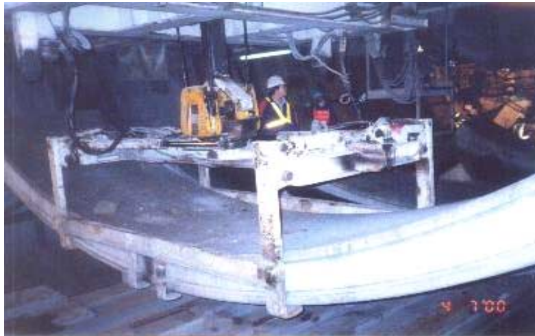
照片3 TBM施工之環片吊裝裝運作業 (資料來源：本計劃參與人員自行拍攝)
