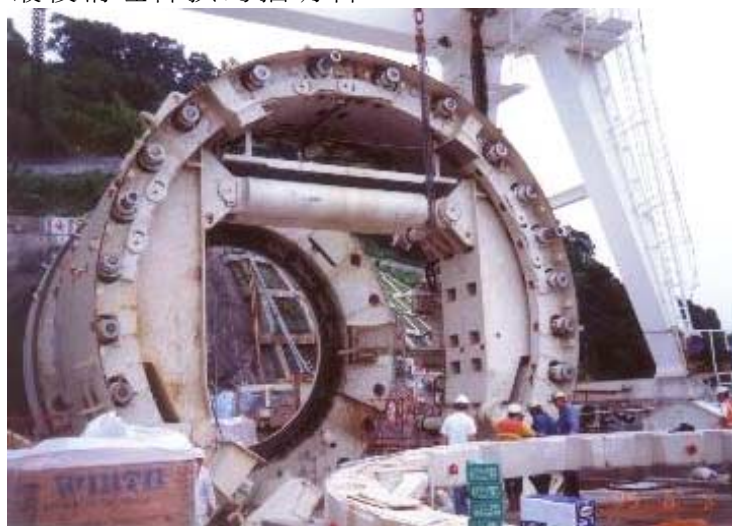
照片1 隧道鑽掘機(TBM)組裝 (資料來源：本計劃參與人員自行拍攝)
