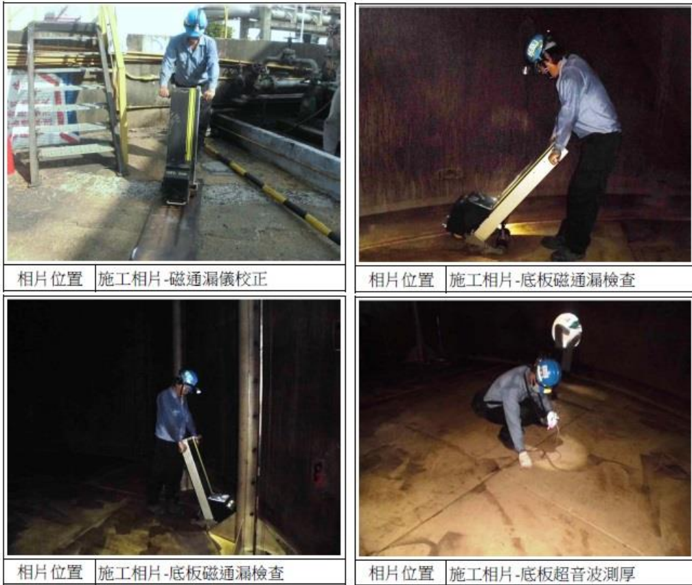
圖 103 儲槽開放後以磁通漏檢測與超音波測厚驗證底板狀況
