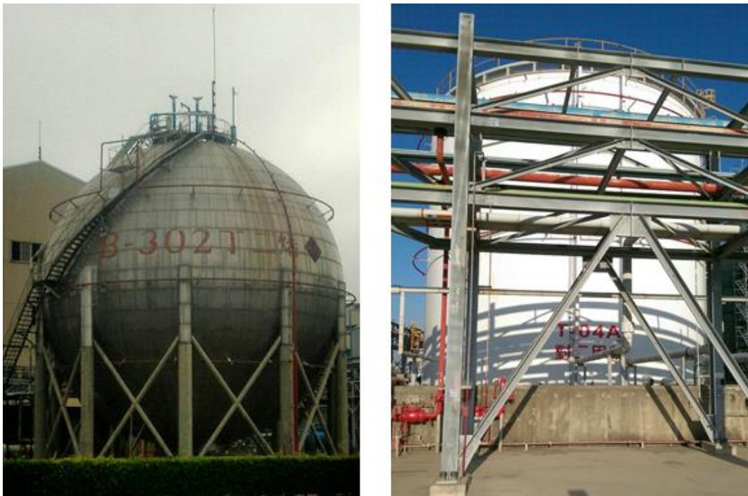
圖 2 壓力容器與儲槽
