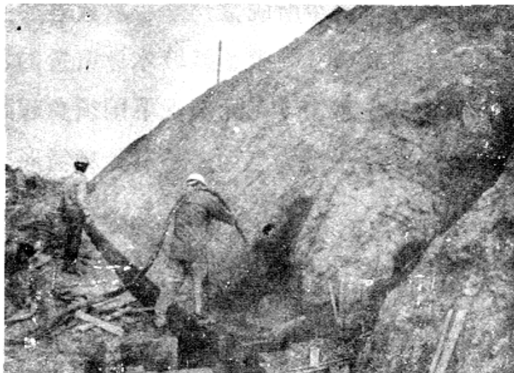
圖1 護坡噴漿作業(資料來源：葉基棟、吳卓夫-營造法與施工)
