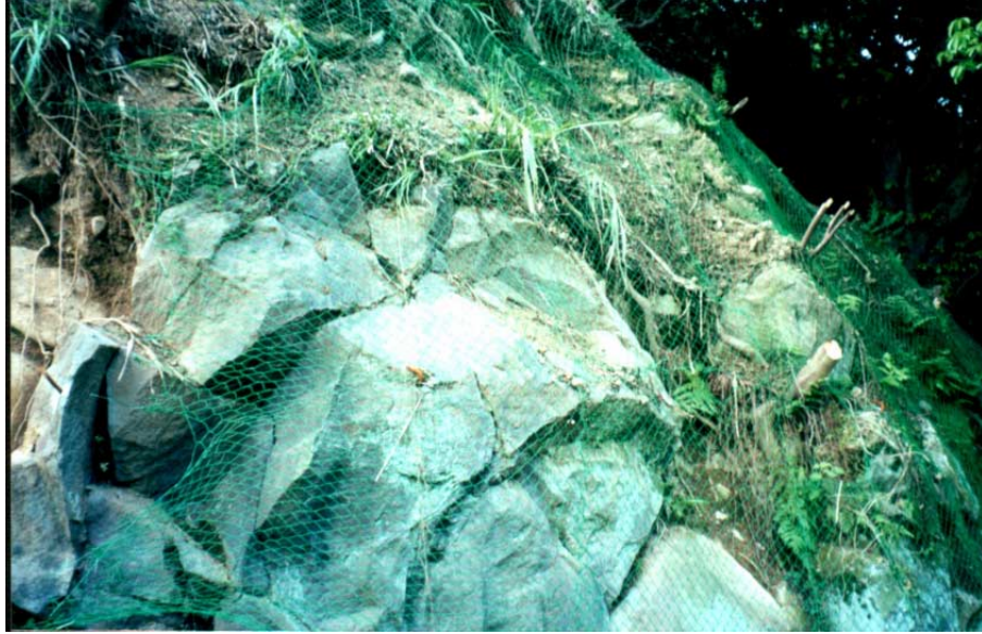
照片1 鋼線網之設置之1(資料來源：台北市工礦安全衛生技師公會)
