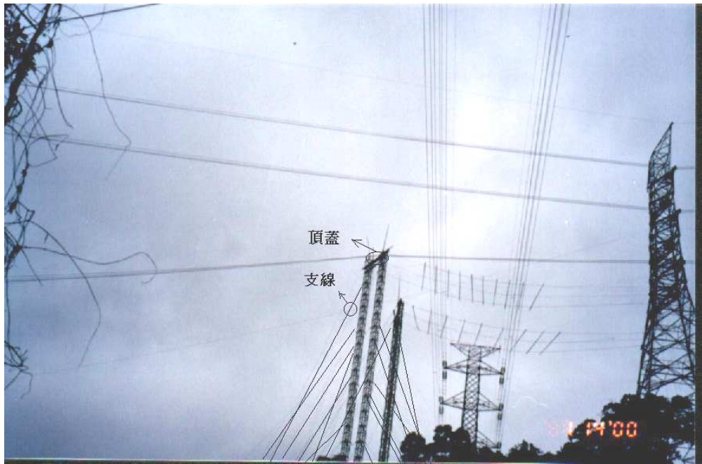
照片1 保護架搭築(資料來源：台北市工礦安全衛生技師公會)
