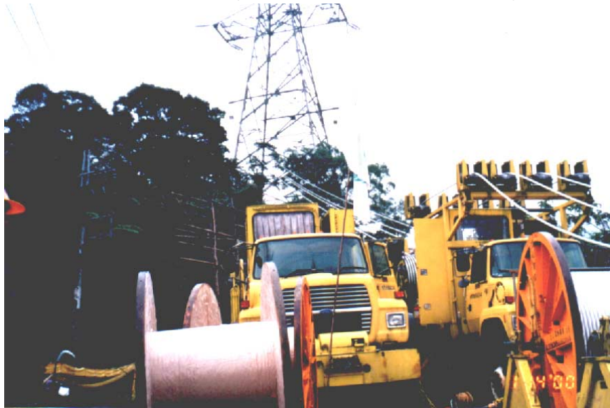
照片2 放線機(資料來源：台北市工礦安全衛生技師公會)
