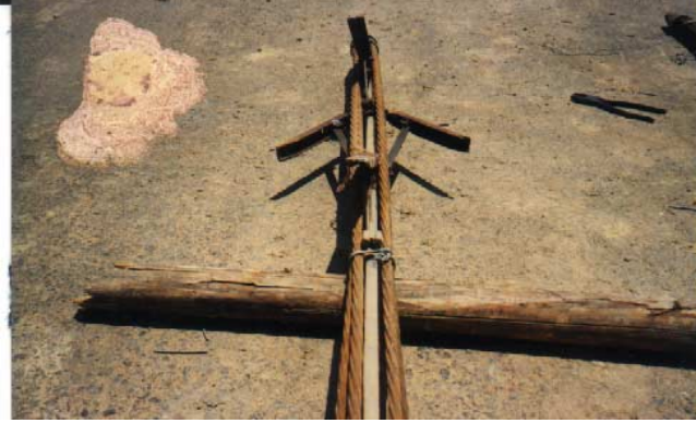
照片1 地錨之預力鋼鍵
