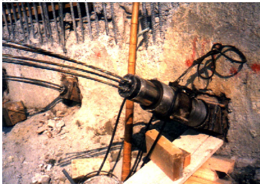
照片4 地錨錨頭錨定情形
