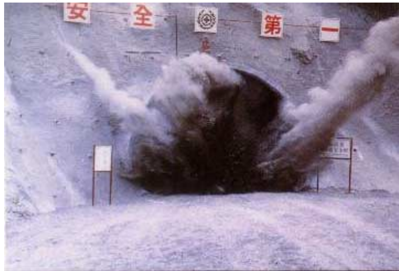
照片4 新奧工法隧道施工之開挖面開炸 (資料來源：本計劃參與人員自行拍攝)
