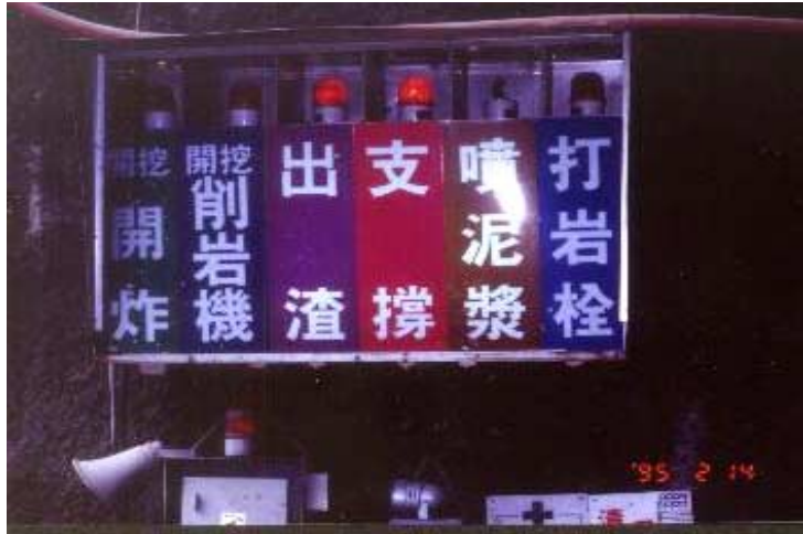
照片1 新奧工法隧道施工作業流程 (資料來源：本計劃參與人員自行拍攝)
