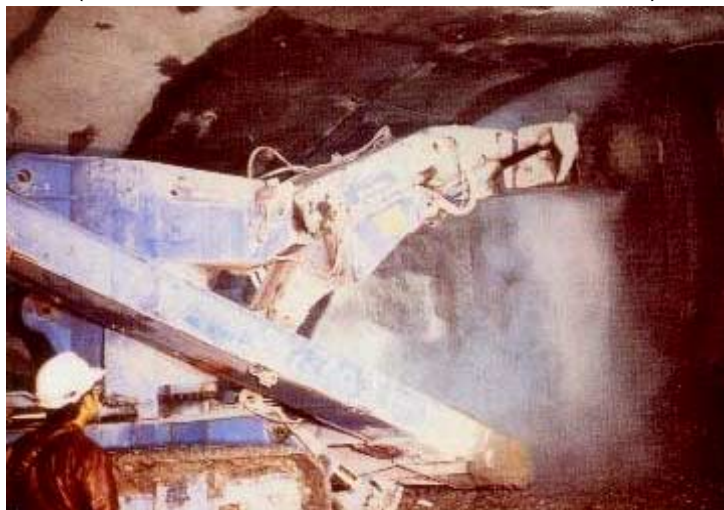
照片5 新奧工法隧道施工之開挖削岩機作業
