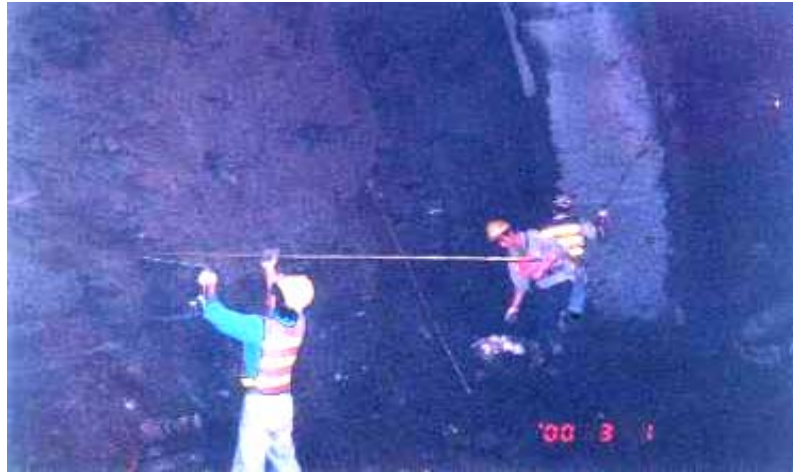
照片3 新奧工法隧道施工之埋設炸藥作業 (資料來源：本計劃參與人員自行拍攝)
