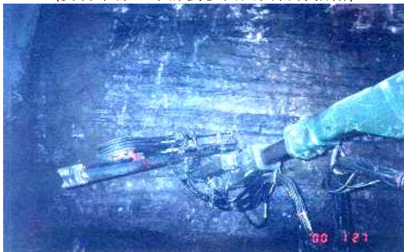
照片2 新奧工法隧道施工開炸孔鑽設作業 (資料來源：本計劃參與人員自行拍攝)
