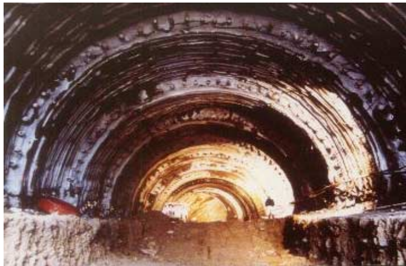
照片7 新奧工法隧道施工之支撐作業
