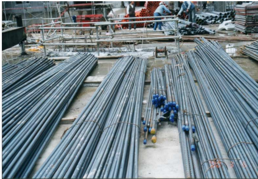
照片2 鋼筋堆放應墊高(資料來源：本計劃參與人員自行拍攝)
