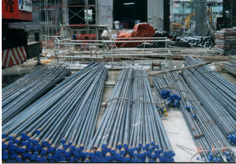
照片1 鋼筋吊掛吊點兩以上(資料來源：本計劃參與人員自行拍攝)
