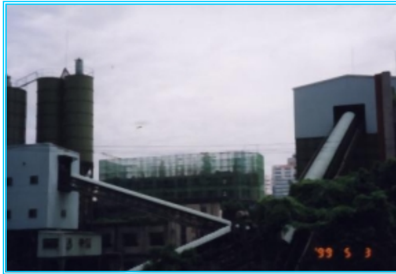
圖1 壓力輸送作業情形(資料來源：摘自施工機械 蔡茂生著)
