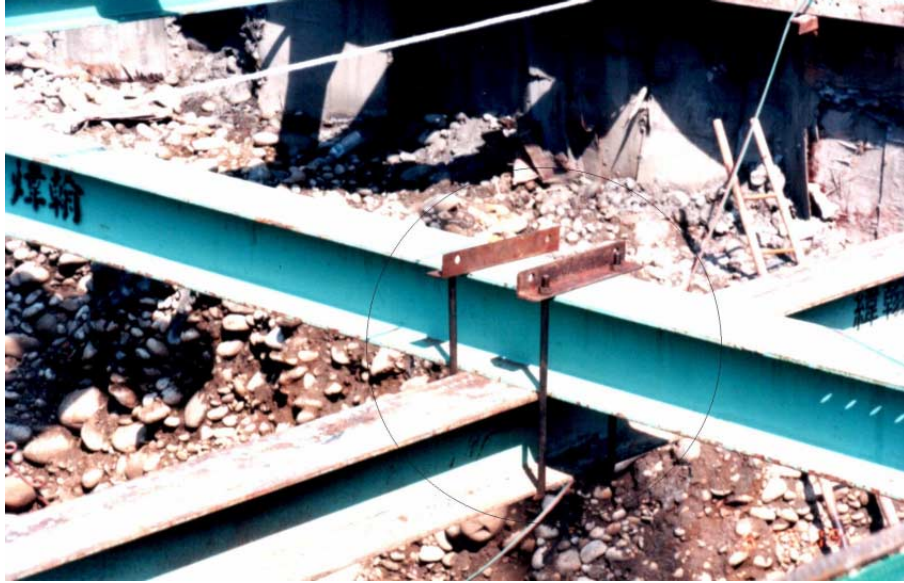
照片4 緊固之U型螺栓(資料來源：台北市工礦安全衛生技師公會)
