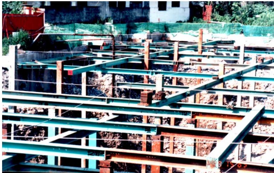
照片1 擋土支撐(資料來源：台北市工礦安全衛生技師公會)
