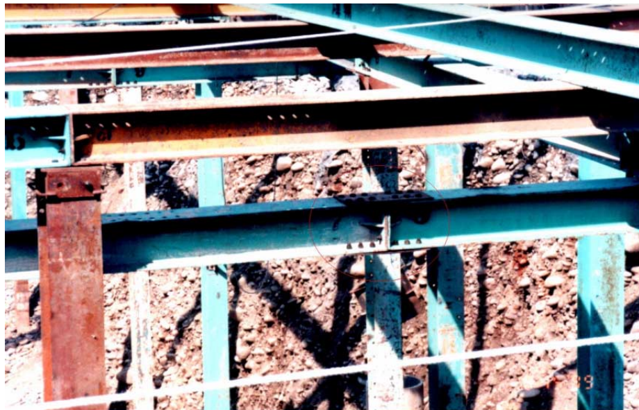
照片3 接合板(資料來源：台北市工礦安全衛生技師公會)
