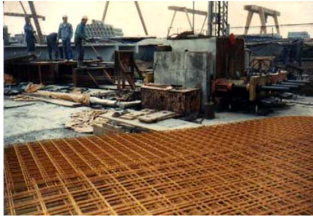
照片1 先拉法之預鑄梁施預力作業 (資料來源：本計劃參與人員自行拍攝)
