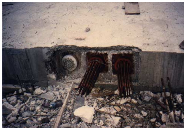
照片6 後拉法之預鑄梁施預力鋼鍵錨錠作業 (資料來源：本計劃參與人員自行拍攝)
