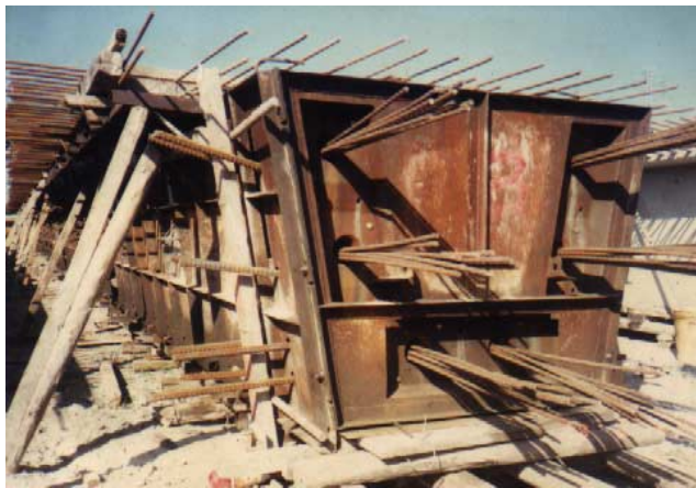
照片7 模板與支撐作業系統
