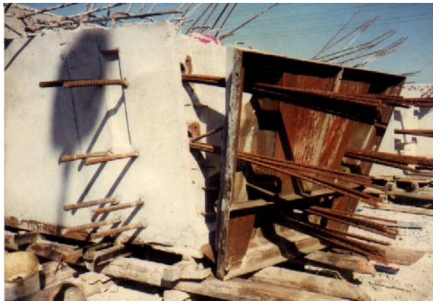
照片5 後拉法之預鑄梁混凝土拆模作業 (資料來源：本計劃參與人員自行拍攝)
