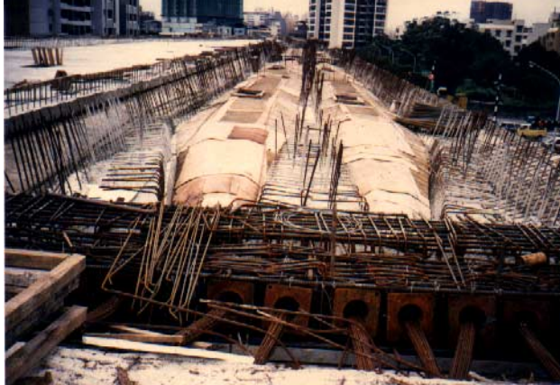
照片4 後拉法之預鑄梁組立鋼鍵及鋼筋作業 (資料來源：本計劃參與人員自行拍攝)
