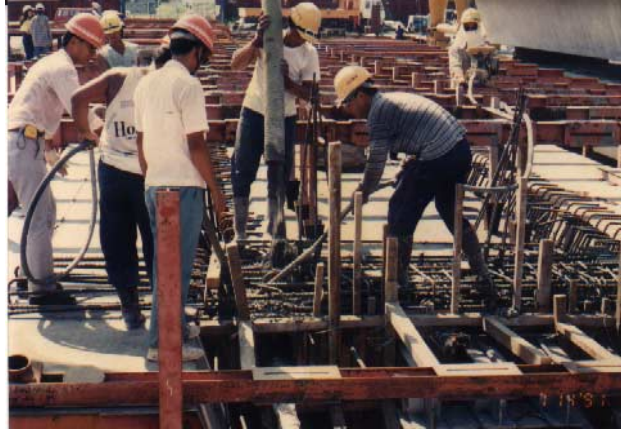
照片9 預力混凝土澆灌作業
