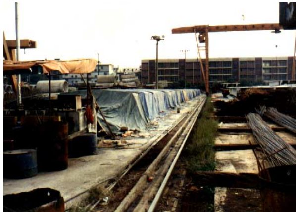
照片2 先拉法之預鑄梁混凝土蒸氣養護作業 (資料來源：本計劃參與人員自行拍攝)
