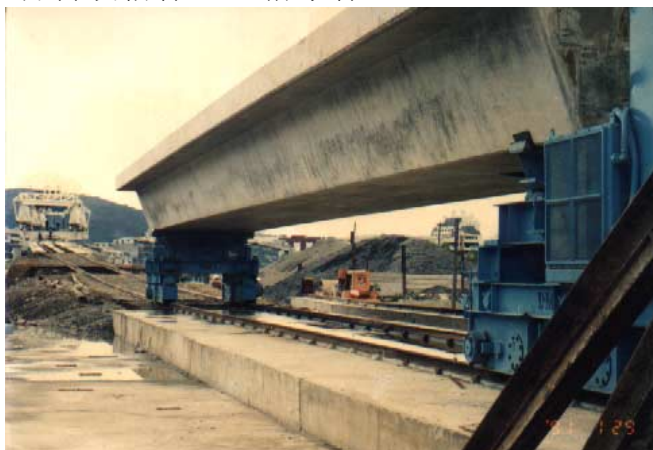
照片11 滾軸或台車輔助架梁作業施工情形 (資料來源：本計劃參與人員自行拍攝)
