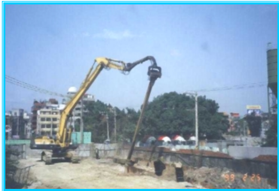
圖1 拔樁機施工現況(資料來源：本計畫)
