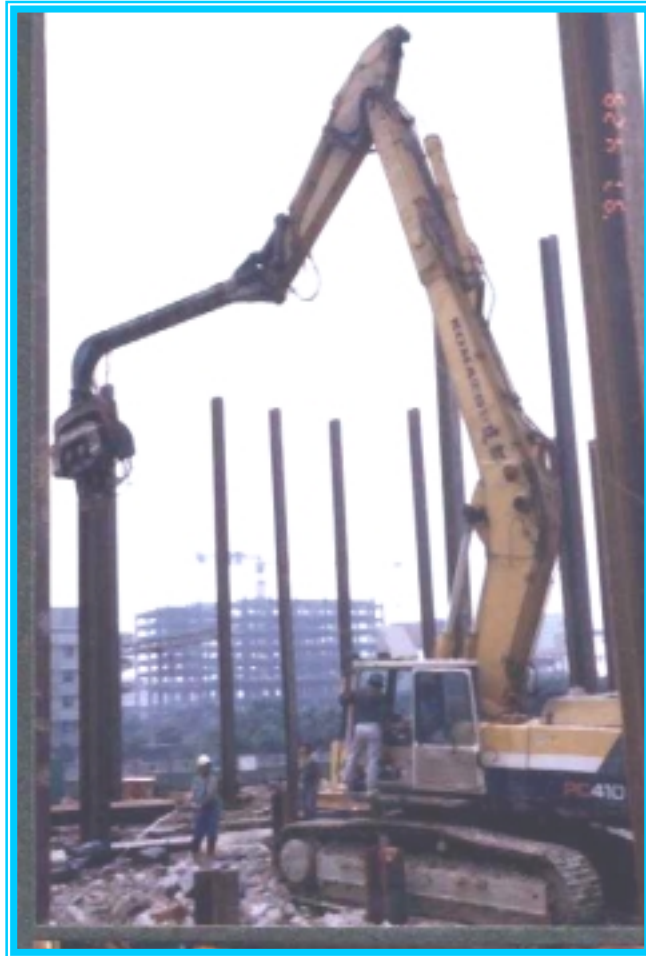
圖1 挖土機改裝之振動式打樁機(資料來源：本計畫)
