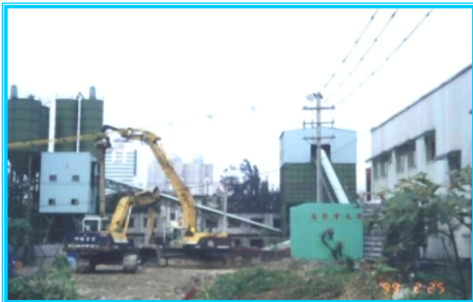
圖2 振動式打樁機(資料來源：本計畫)
