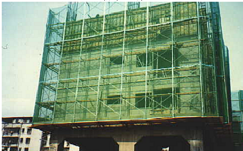
照片4 施工架應組立確實並定期檢查(資料來源：根基營造(股)公司)
