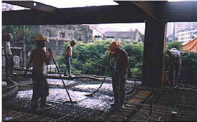
照片3 混凝土澆置中應加強對模板之監視及補救(資料來源：根基營造(股)公司)
