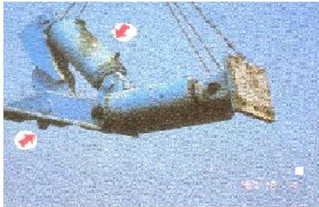
照片3 節塊推進之煞車千斤頂
