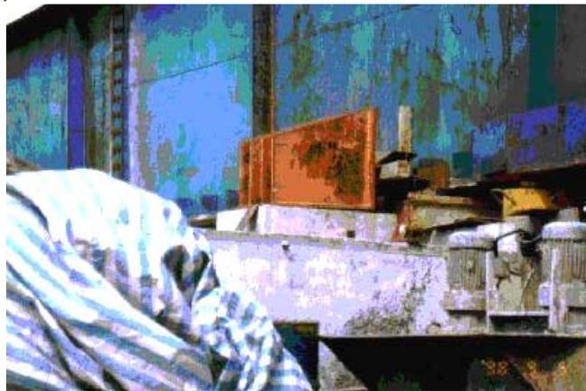
照片1 節塊推進之側制導架
