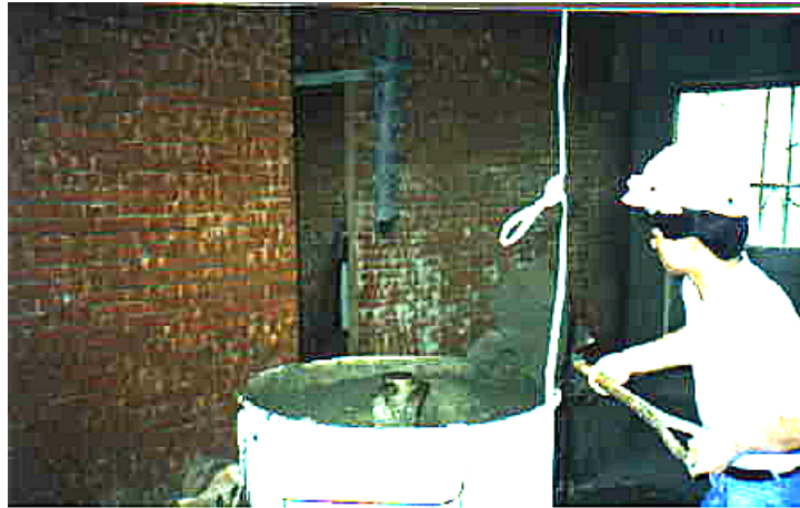
照片4 磚牆作業之拌合膠結材(資料來源：根基營造(股)公司)
