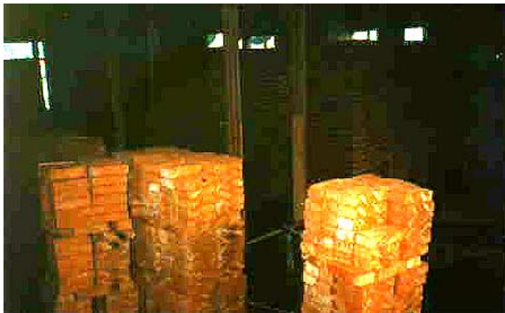
照片1 妥善規劃材料堆放位置(資料來源：根基營造(股)公司)
