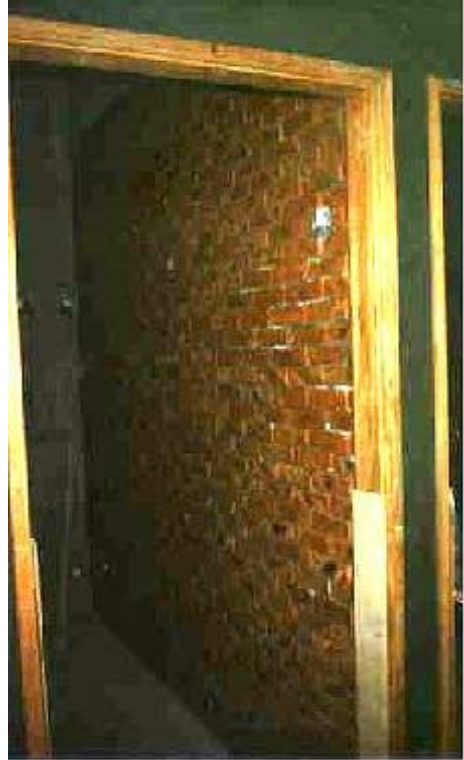
照片3施工應確實依規範施作
